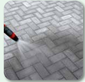
Fläche ausreichend wässern. Nachbehandlung beachten!
