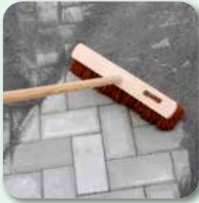
vdw VarioSand einfegen und von der Oberfläche abfegen
