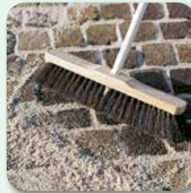
mittels feuchtem Besen abfegen
